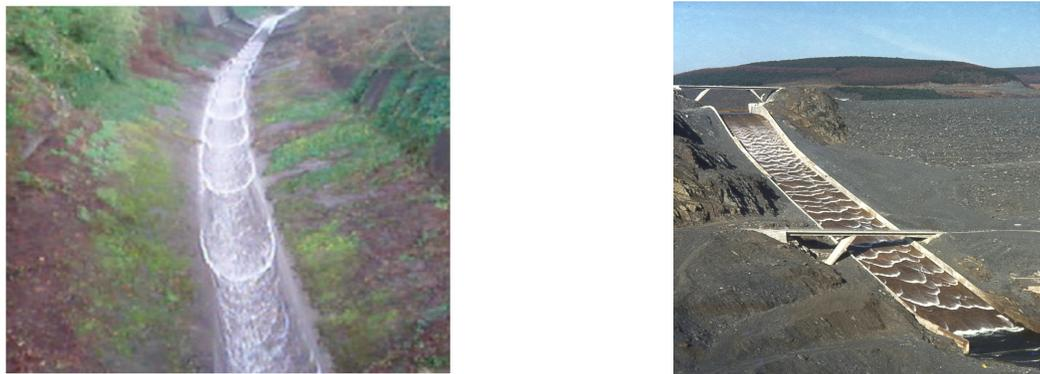
FIGURE 4 – A gauche : Roll-waves régulières. A droite : Instabilités transverses de roll-waves
